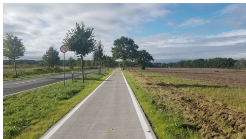
Runderneuerter Radweg Erbstorf - Ebensberg
