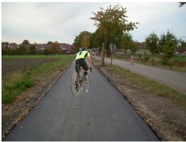
Runderneuerter Radweg Reppenstedt - Schulzentrum Oedeme
